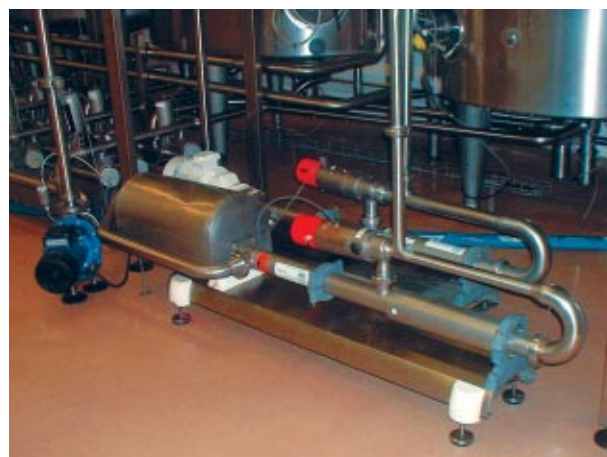
Насос 13N12, с байпасом для очистки на месте на участке свежих молочных продуктов для дозирования сливок
