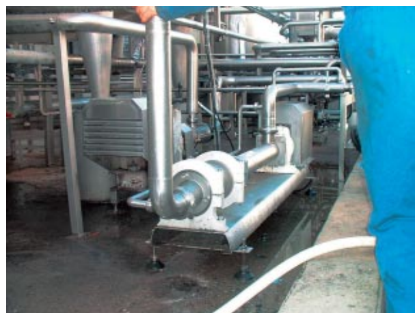
Насос 25N6 Молочная промышленность. Перекачивание растительного масла в танк-накопитель
